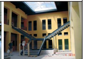
Möbelhaus Bracker, Hanau
